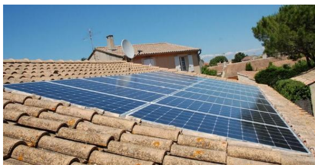
Intégration sur le plan de toiture
