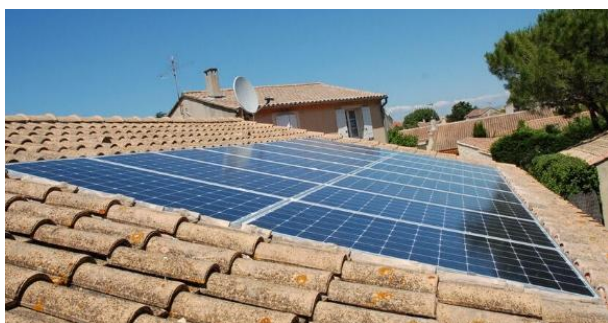
Intégration sur le plan de toiture
