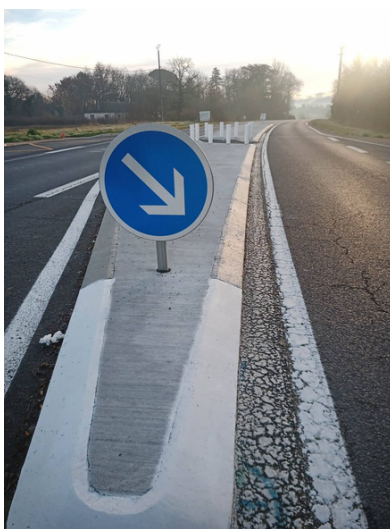
Aménagement carrefour D631
