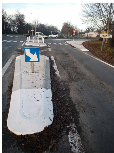
Aménagement carrefour D39
