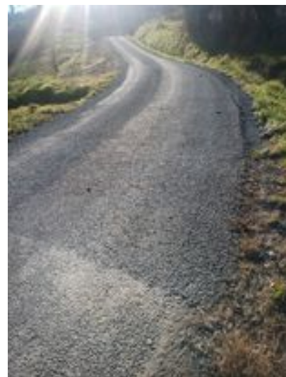
Reprise chaussée sur 100 m suite grande pluie février route de la Marqué glissement de terrain
