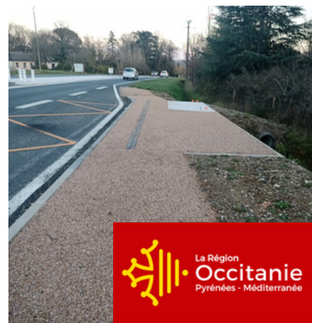
Emplacement abri-bus (abri-bus en cours de livraison)
