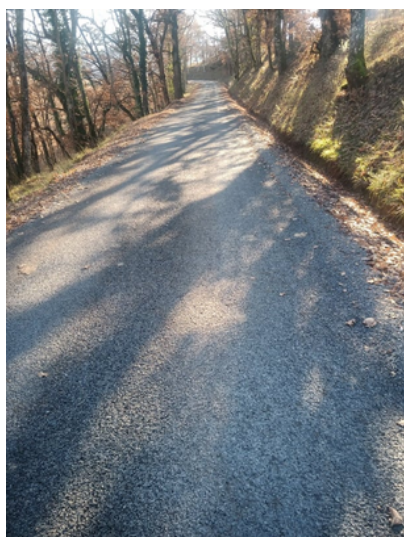
Route de la Parayrié réfection de voirie sur les 2/3 . Fin des travaux 2022
